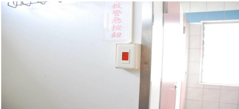
(六) 校區各樓層女廁單間警示鈴 提供如遇緊急事故狀況時可迅速求救使用。
