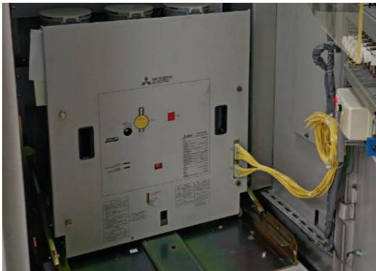
《I 棟真空斷路器汰換後現況》
